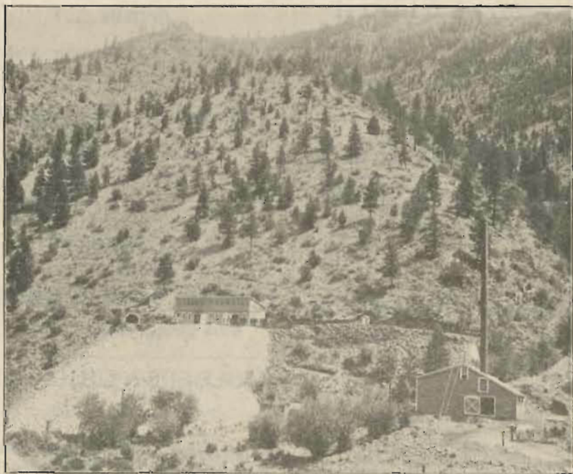
Portalen till Lucania Tunneln visande älven den nuvarande smedjan och kraftstationen, som ägas af bolaget.
