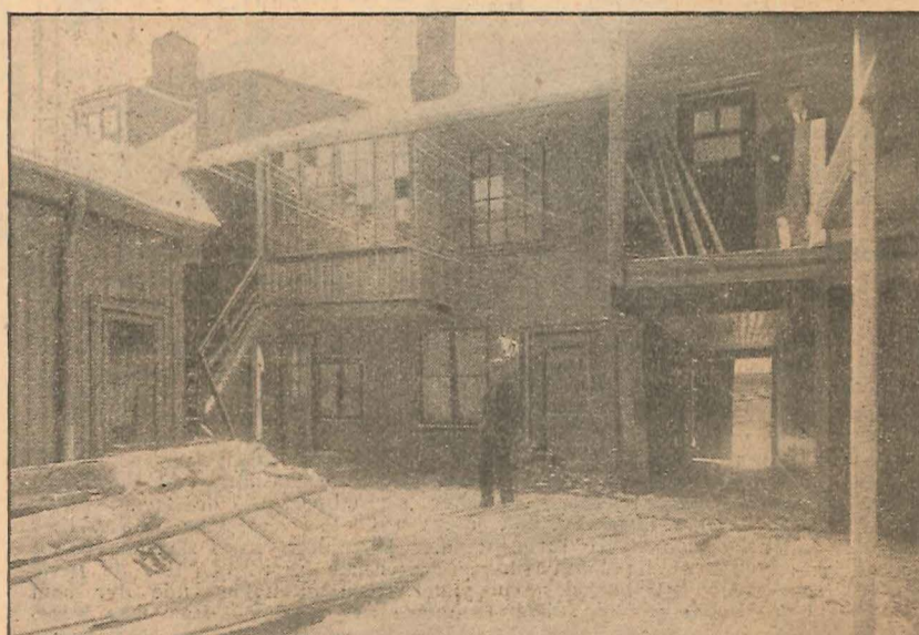
I denne fortvilede husnødtid bor mange mennesker under elendige forhold, og de nystiftede leieboerforeninger søker da gjerne at ta affære. Fra ovenst. miserable husklynge flyttet saaledes Kr. a. leieboerforening forlenne med flere barn. — Fot. Skarpmoen.
