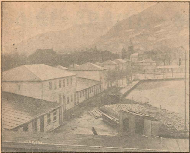
Parti fra barakkebyen i Bergen, ved Lille Lungegaardsvand, ogsaa kaldt „Flisebyen“, hvor en række forretningsdrivende maa kampere, indtil de nye forretningsgaarde blir reist efter branden. — Fot. Nyblin.
