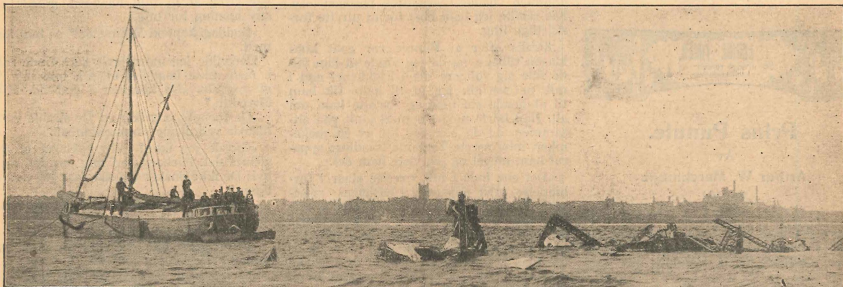
Dette er de sørgelige rester av det store luftskib „Z. R. 2” som under sin første prøvofart styrtet ned i Humberfloden ved Hull. Luftskibet eksploderte, knækte tversover i to stykker og styrtet brændende ned. Bare 5 av den 46 mand store besætning overlevet den sørgelige katastrofe som vakte rædsel hos de mange tilskuere og har gjort et nedslaaende indtryk saavel hos det store publikum som inden de kredse der arbeider med luftproblemerne. Man ser her et fartøi søke at bjerge enkelte stykker av det ødelagte luftskib. „Z. R. 2” var av den amerikanske regjering bestilt i England, og man imøtesaa dets fart over Atlanterhavet med store forventninger.
