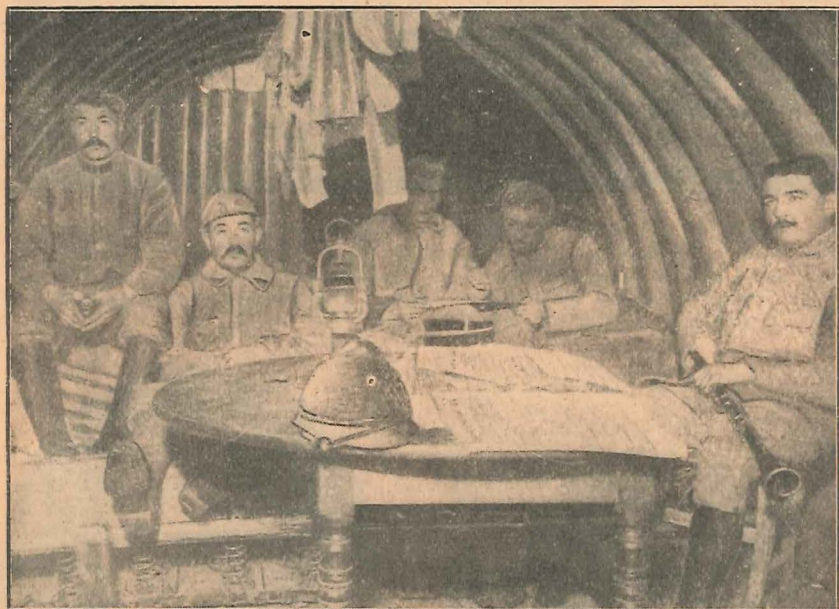
I et av franskmændenes bombesikre rum ved Verdun. Som man av billedet ser er rummets tak beskyttet ved staalbuer, og naar de franske stillinger har kunnet byde tyskerens voldsomme bombardementer saa seig en motstandskraft, skyldes det sikkert i fremtrædende grad disse konstruktioner.
