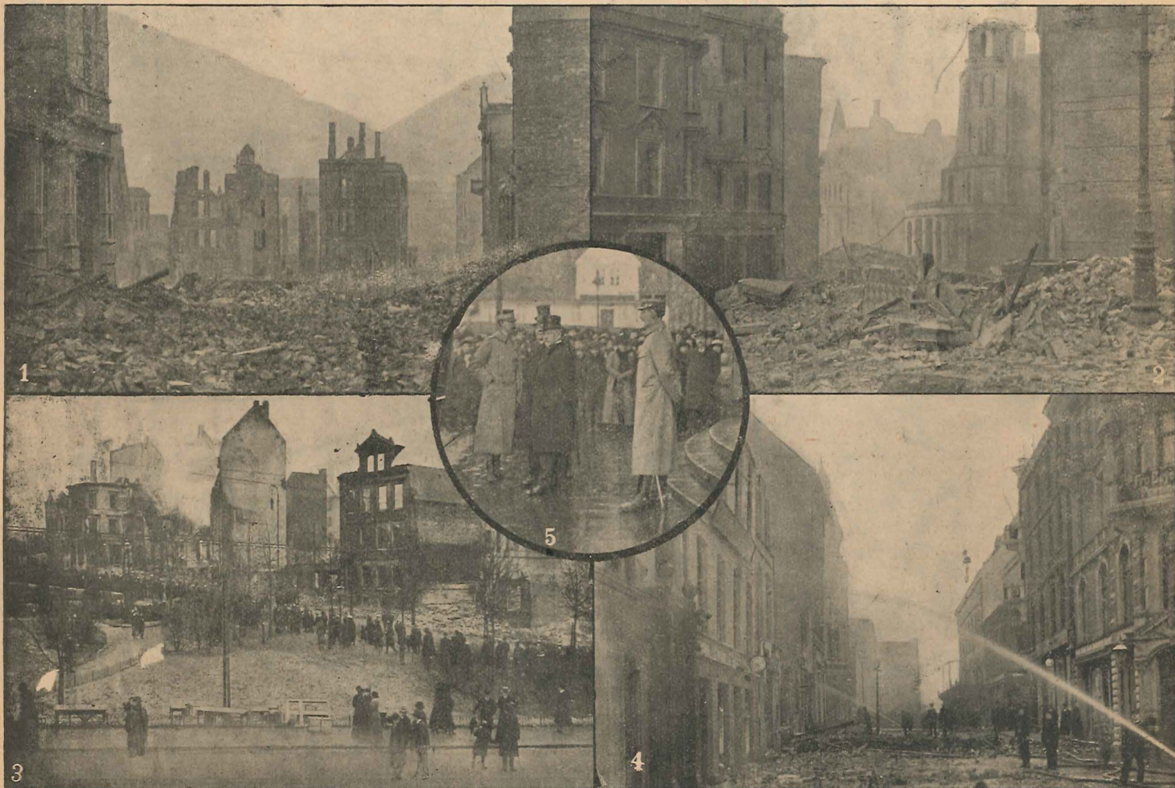
Bergens centrale strøk i aske. 1. Muren mot Strandgaten, hvor ilden begyndte. 2. Veiten med den nye telefoncentral, hvis moderne bygemaate stod sin ildprøve. 3. Ved Engen hvor ilden begrænsedes mot vest, saa teatret reddedes. 4. Slukningsarbeide i Smastrandgaten, brandens sydøstlige grænse. 5. Kongen kommer til Bergen for at bevidne byen nationens deltagelse. — Fot. Harald Nilsen og fat. Madsen.
