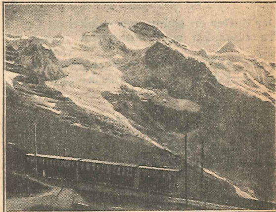
Den elektriske tandhjulsbane, som delvis inde i fjeldet, delvis utenpaa fjeldvæggen klatrer op til Jungfrauoch i over 3400 meters høide. Mellem skinnene ligger tandhjulstangen, i hvis tænder lokomotivet biter sig fast.
