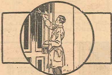
Fig. 25. For ikke at faa maling paa rutene holder man et tyndt stykke blik for naar man stryker vinduskarmen.
